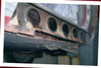
Auch die Türschweller wurden im Zuge der Restaurierung erneuert.
